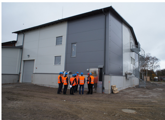
Bild 4. Tillbyggnad för membranläggning
